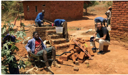
マラウイでの資源循環型トイレの建設現場にて
